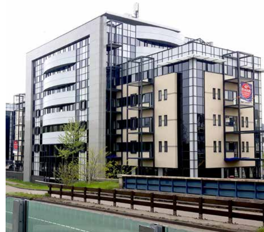
Aan de buitenzijde zijn balkons toegevoegd in de vorm van een staalconstructie.
